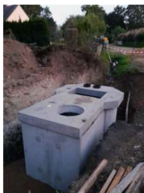
Installation d'une pompe de relevage
